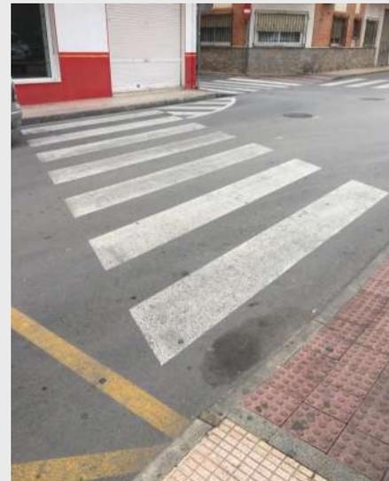
Adaptar pasos de cebra con rebajes a ambos lados y pavimento señalizador
