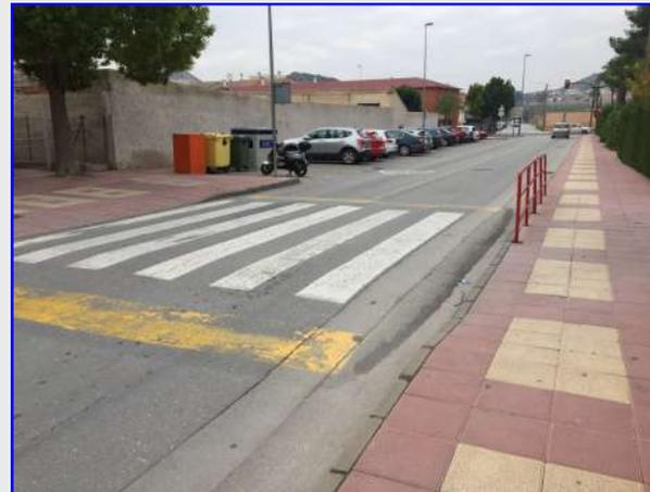
Ajustar el desnivel entre la cota del paso peatonal sobre resalto y la cota de la acera
