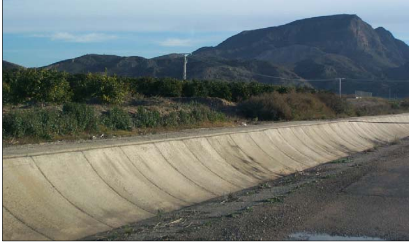
Imagen 4. Rambla de Santomera. Encauzamiento y camino de servicio de la CHS.
