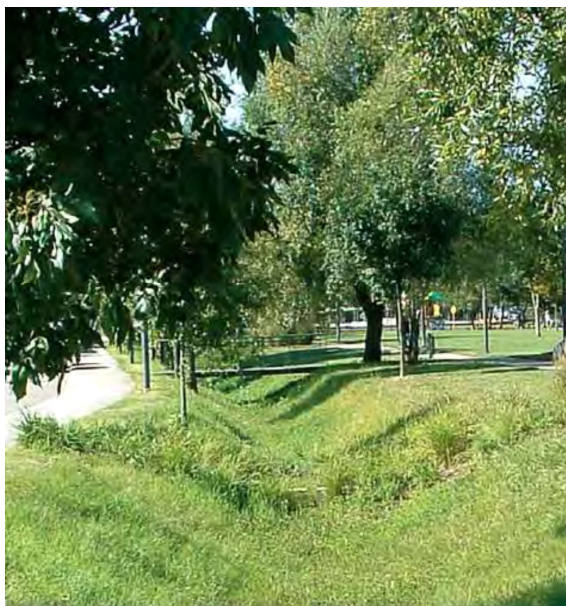
Detalle de medidas de captación de agua de lluvia en zonas verdes recomendado por el manual de la Unión Europea y según informe de Confederación Hidrográfica del Segura. (NWRN)
