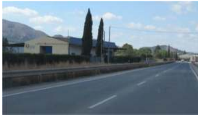
Fotografía 19. Carretera y naves colindantes.
