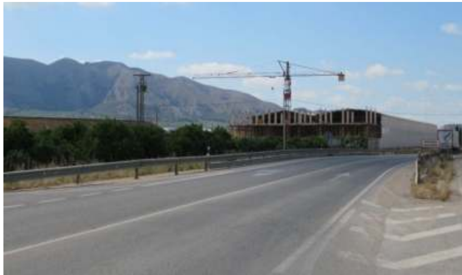
Fotografía 2. Apreciación de las edificaciones ya existentes entre la carretera RM-414 y el P2.
