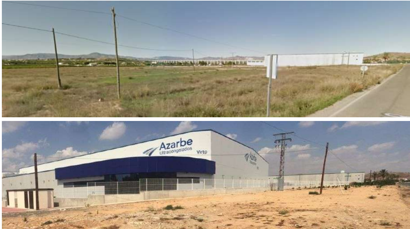
Imagen 11 e Imagen 12. Comparativa de la zona antes y después de las obras.
